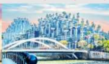
อาคารพินตันโม
